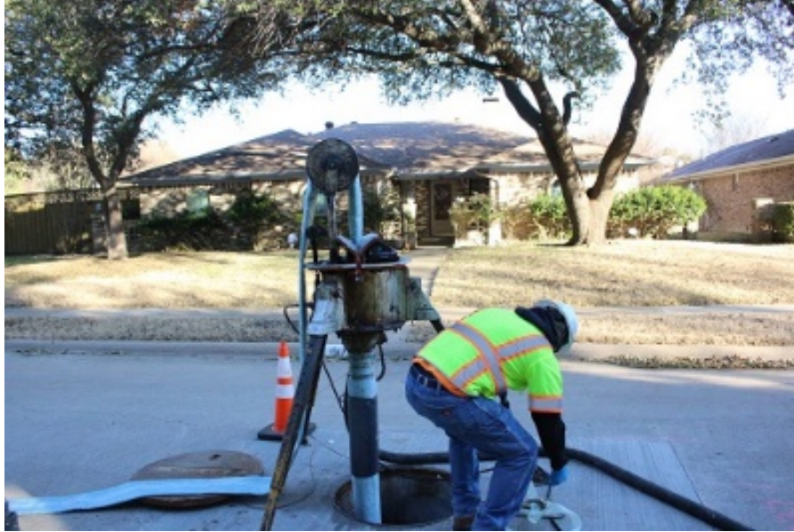
Figure 1-11 Inlet Manhole (Kaushal et al., 2019)
