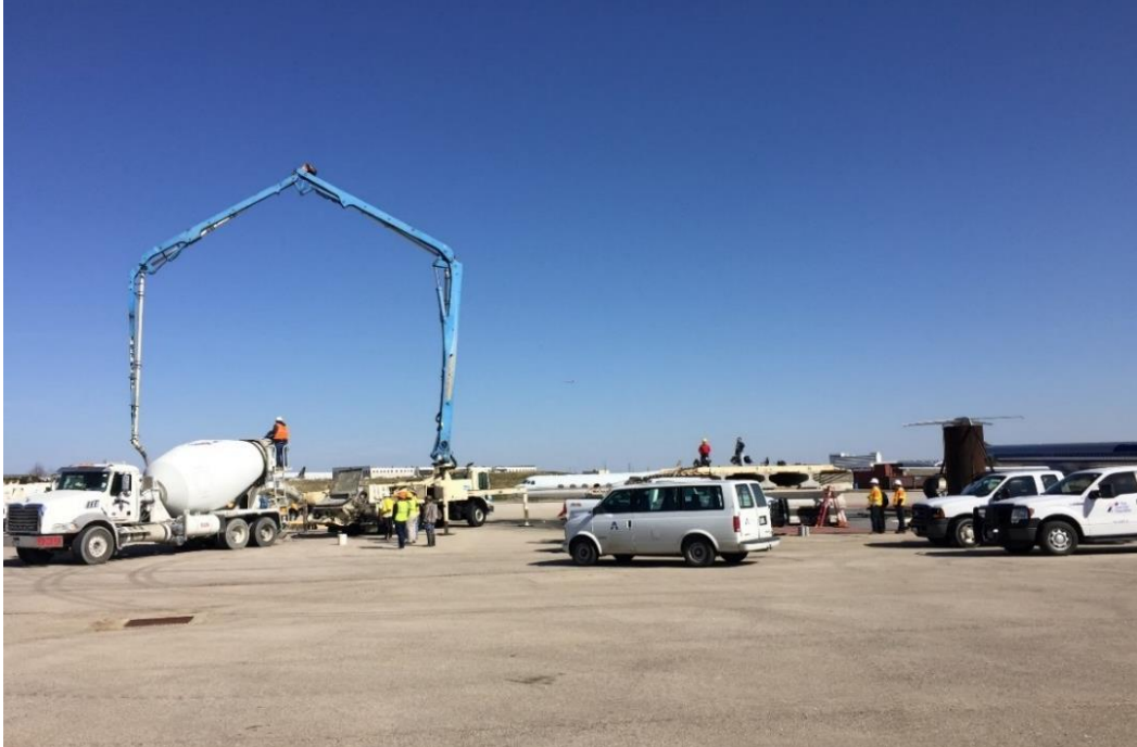
(d) Concrete pump
