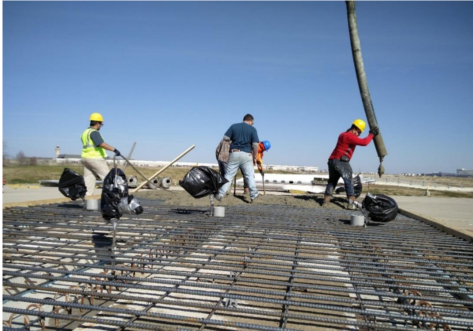
(e) Deck concrete pour
