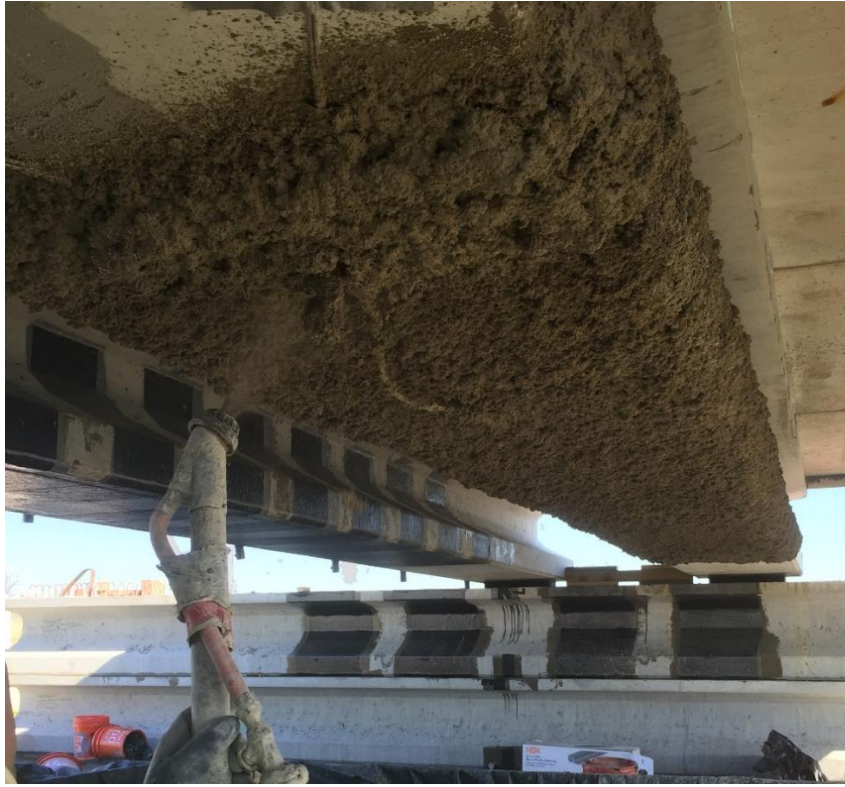
(d) spray applying of fireproofing
